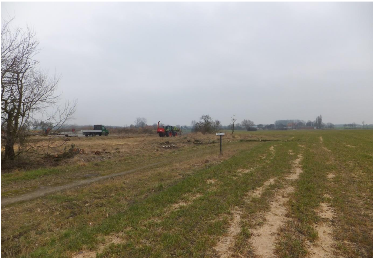
Blick auf die Parzellen 1202 + 1203 nach den Rodungsarbeiten
