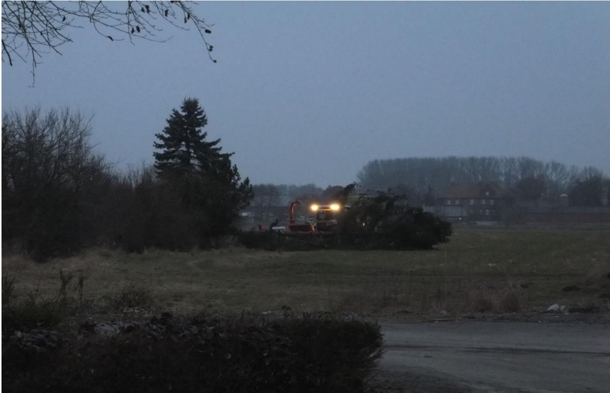
Beginn der Rodungsarbeiten am 09.02.2017 auf den Parzellen 1202 + 1203
